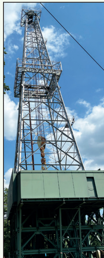
Auf dem Freigelände erhebt sich das riesige, über 50 Meter hohe Bohrergerüst.
