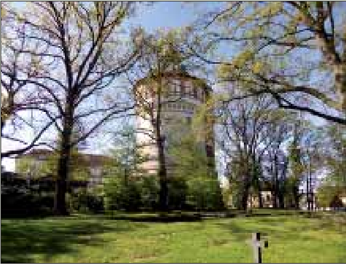
Sehr oft liegen die schönen Bauten mitten in unserer Stadt. Max Osterloh, ein Braunschweiger Baumeister, ließ den Wasserturm 1901 errichten. Foto: E. Qweitzsch
