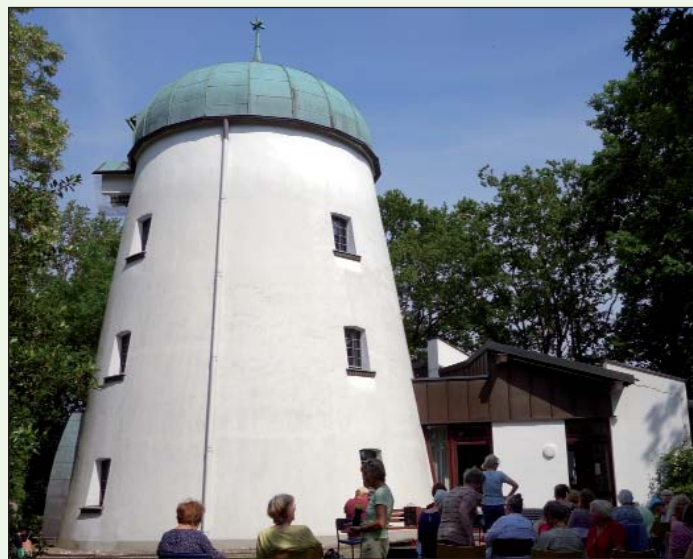
Die ehemalige Mühle, heute Mühlenkirche.
