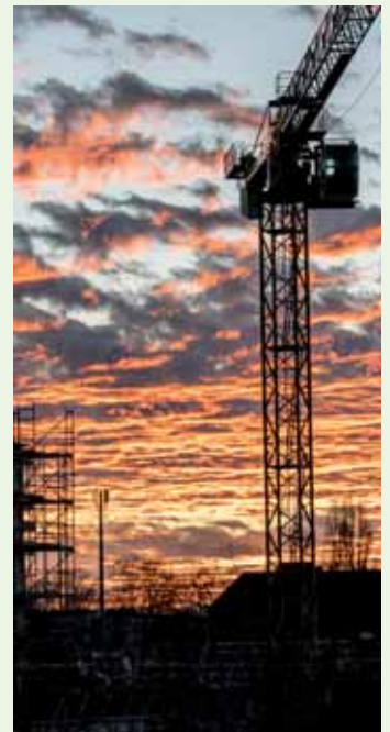
Abendlicher Himmel im Baugelände Praktikergelände.
